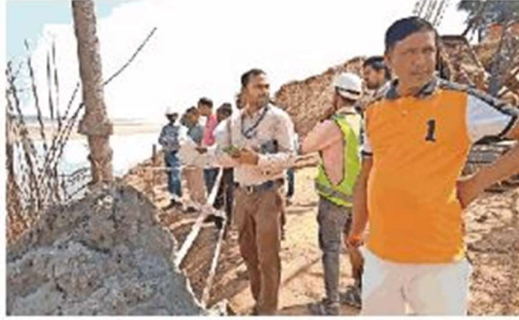
अमलीकौर में जल जीवन मिशन के तहत निर्माणाधीन पेयजल परियोजना का निरीक्षण करते अधिकारी ● गेई
